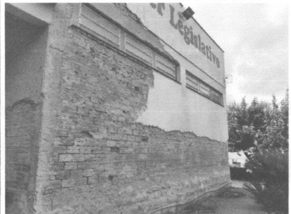
Imagem da fachada externa frontal, onde o reboco já está sendo removido.
