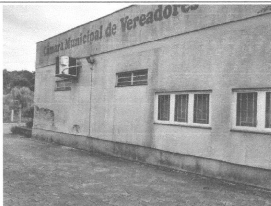
Imagem da fachada externa lateral, onde o reboco ainda não foi removido.
