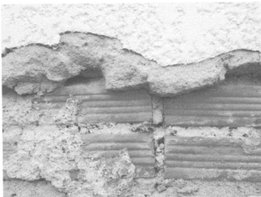
Imagem do revestimento externo, onde observamos a espessura do reboco existente.
